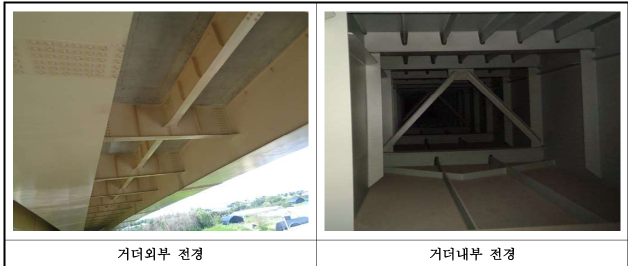
【사진 3.3.4】 거더 전경
