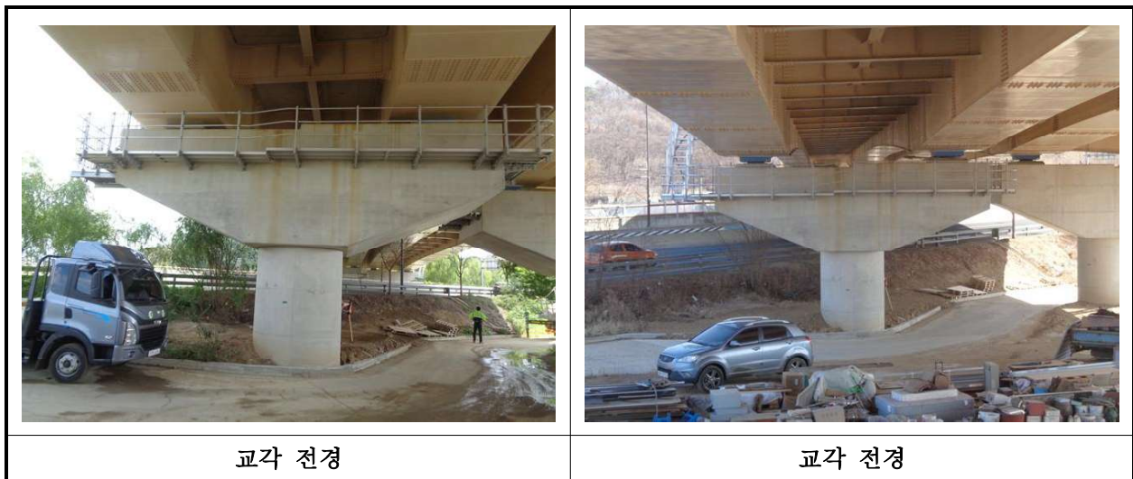
【사진 3.3.10】 교각 전경
