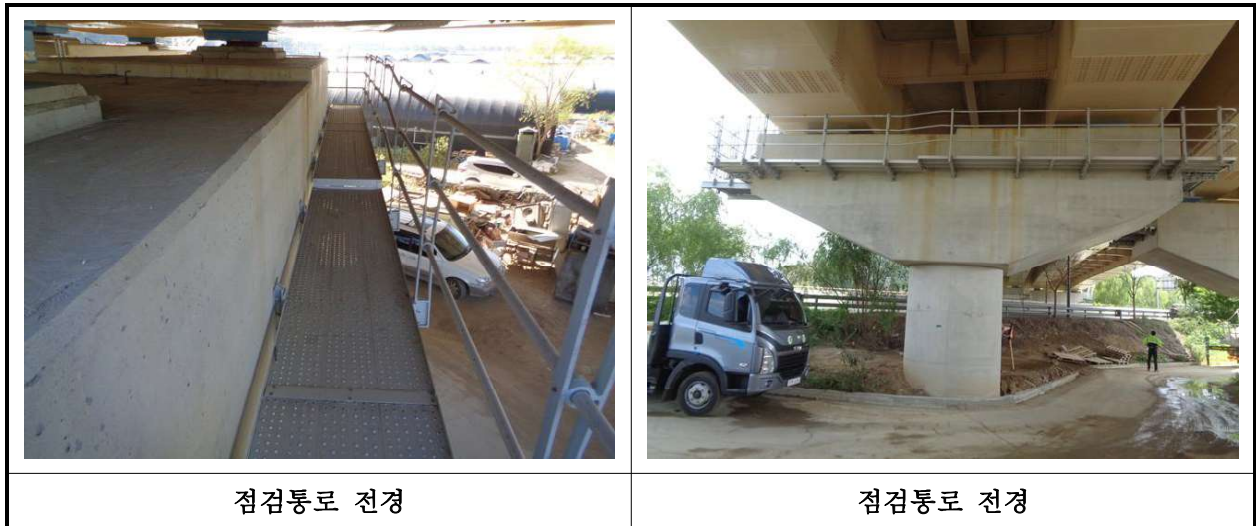
【사진 3.3.25】 교량 점검시설 전경
