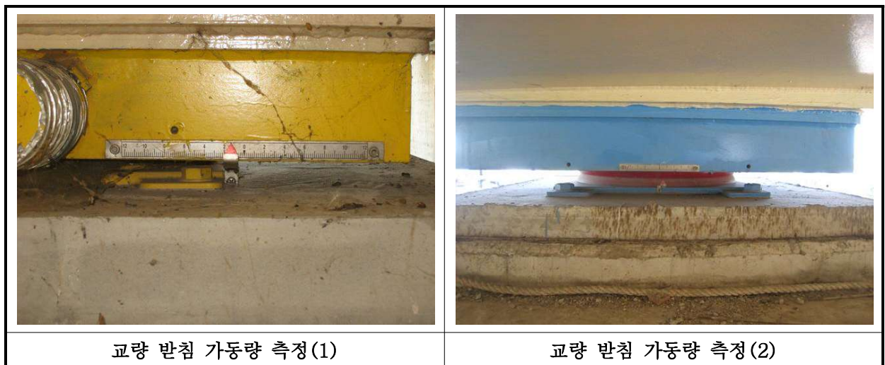
【사진 3.3.15】교량받침 이동량 측정
