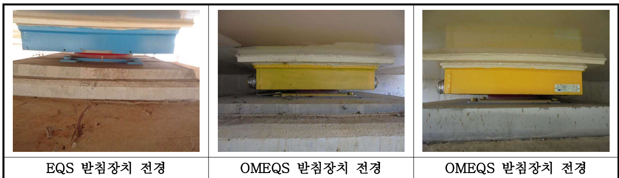
【사진 3.3.12】 교량받침 전경
