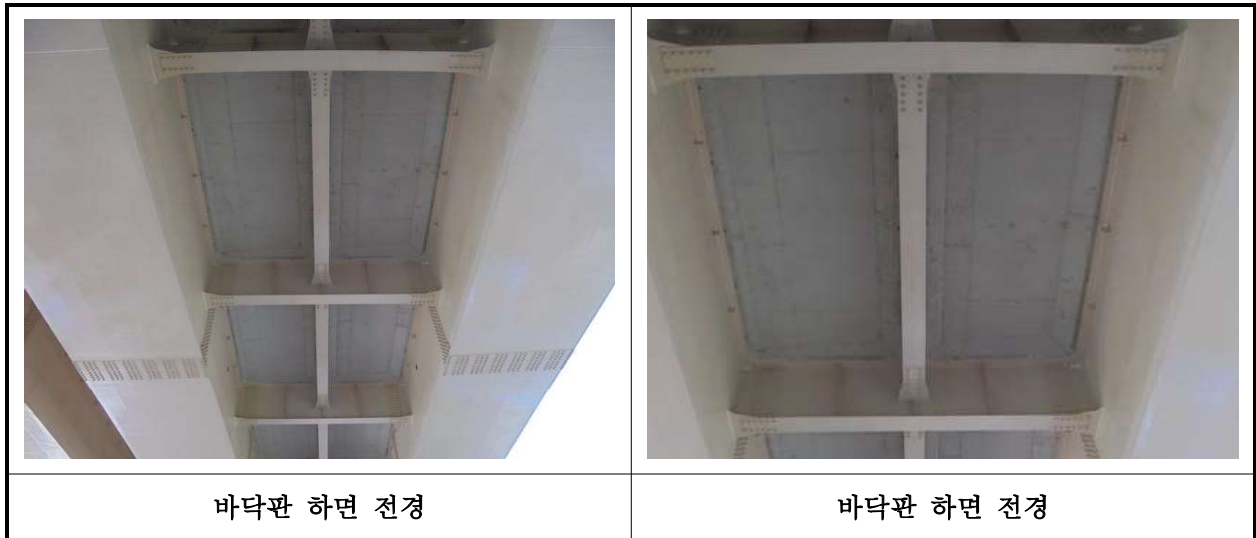
【사진 3.3.2】 바닥판하면 전경
