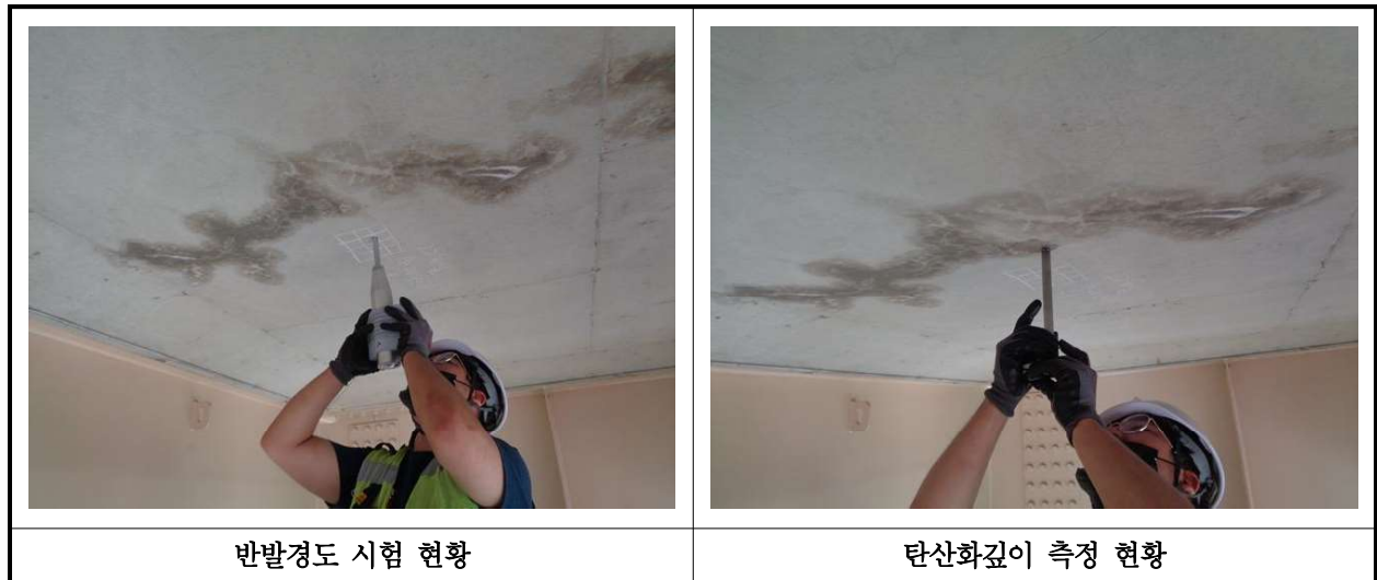
【사진 3.4.1】 콘크리트 내구성조사 현황
