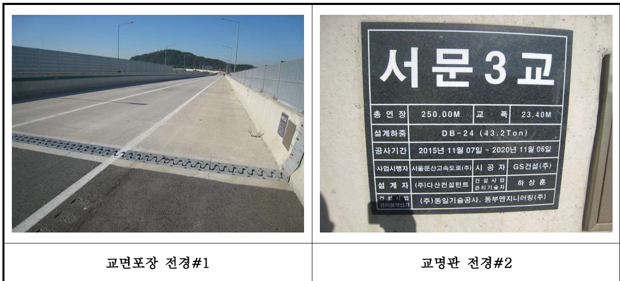
【사진 3.3.19】 교면포장 전경
