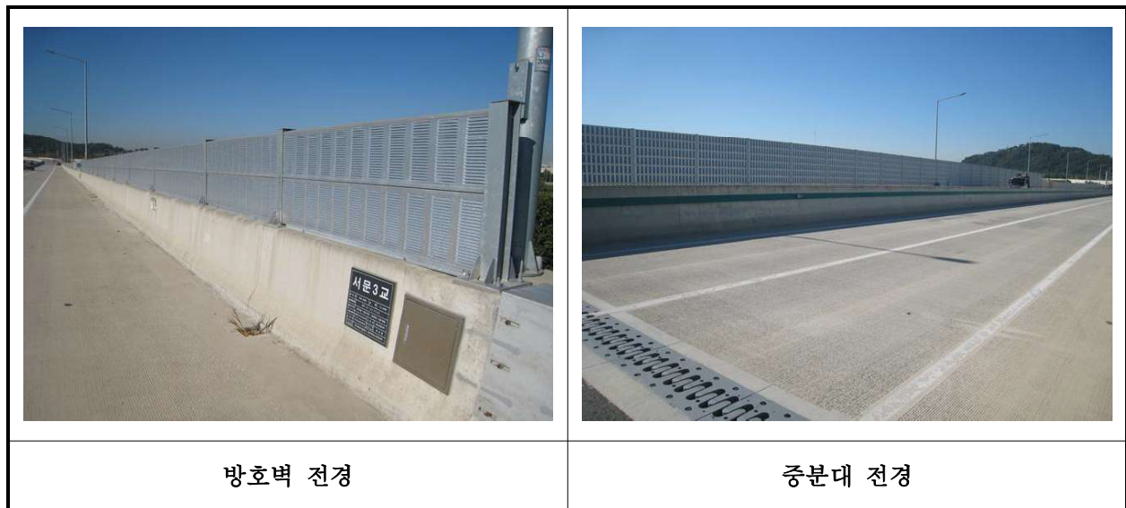
【사진 3.3.23】 방호벽 및 중앙분리대 전경
