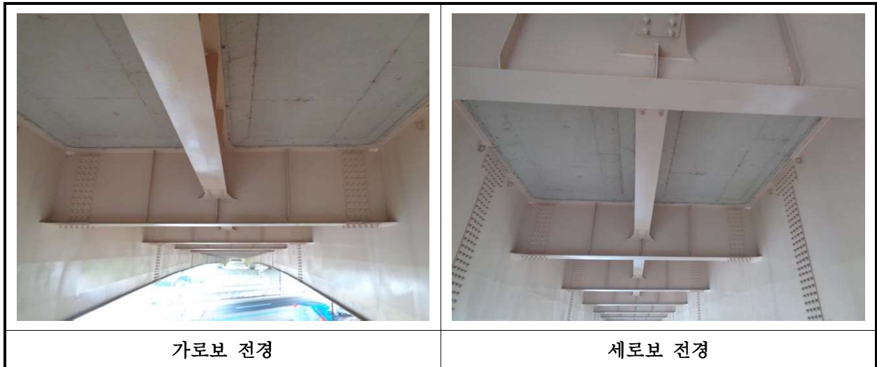
【사진 3.3.6】 가로보 및 세로보 전경
