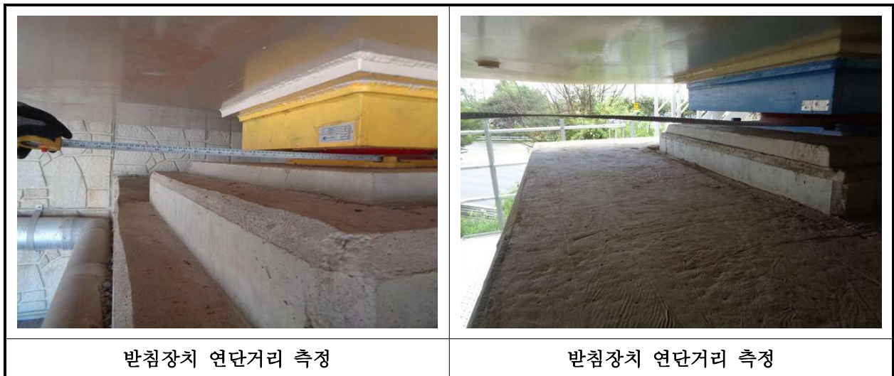
【사진 3.3.14】 교량받침장치 연단거리측정
